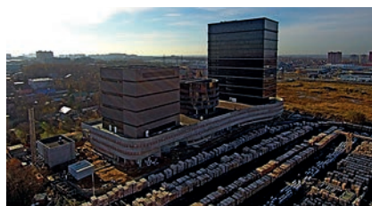
Офисно-складской комплекс (г. Москва, г. Щербинка, ул. Кутузова, 12)
