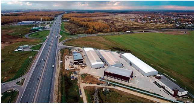
Многофункциональный комплекс придорожного сервиса (Московская область, г.о. Подольск, д. Бережки)
