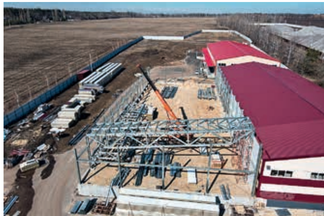
Склад-пристройка (г. Воронеж)
